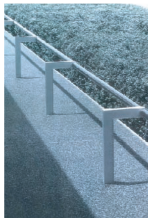
デザインされたガードフェンス
